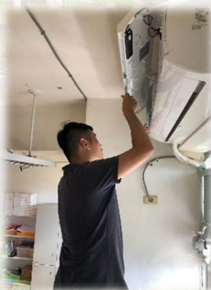
圖 60、清洗冷氣濾網
