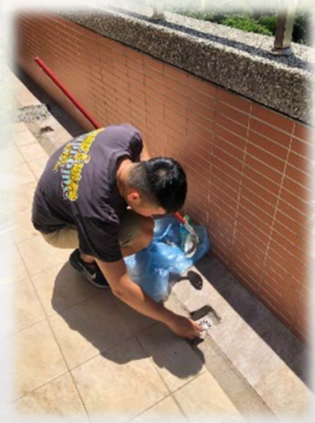
圖 57、處理水溝淤積
