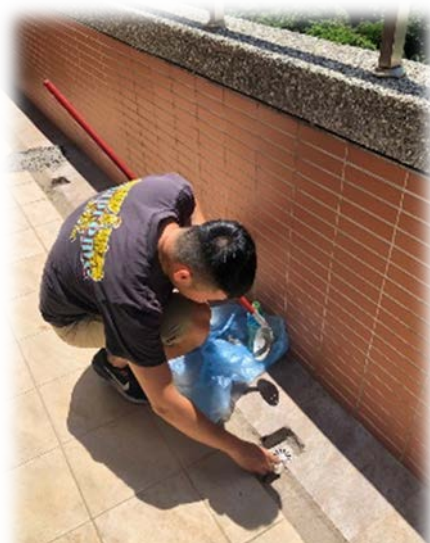
處理水溝淤積
